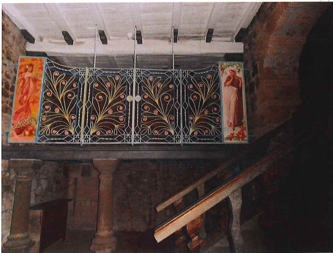
10) SOPPALCO VISTO DAL LOCALE COMMERCIALE SOTTOSTANTE IL P. TERRA
