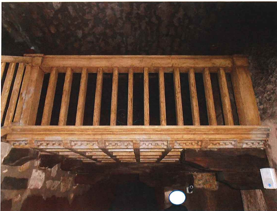
15) SOPPALCO ALL'INTERNO DELLE CANTINE
